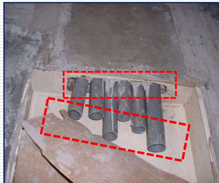
管口未施作喇叭口， 配管接續開孔應密合
