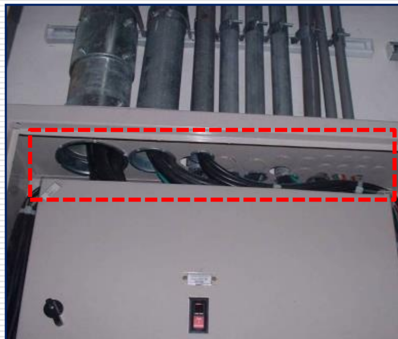
配電盤配管使用既有預留 孔未任意切割，且有喇叭 孔施作
